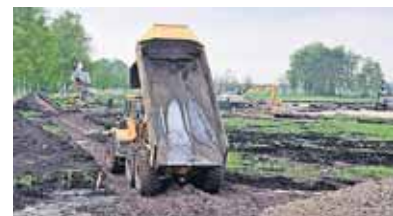
Großbaustelle Torfhafen – in den vergangenen Wochen liefen vor allem die wasserbaulichen Arbeiten auf Hochtouren.
